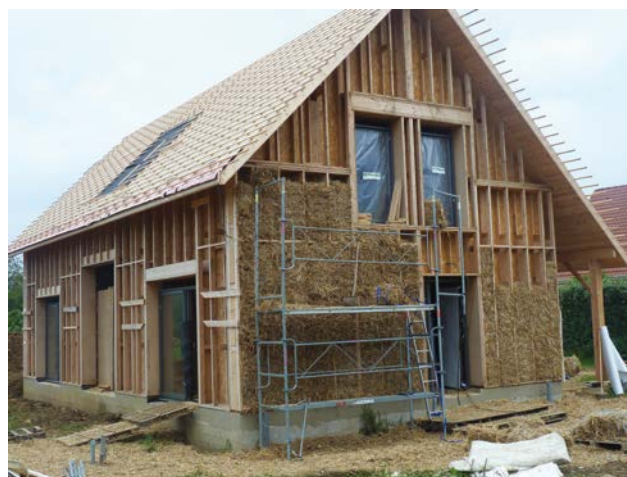
De realisatie van een individuele woning in Pittefaux (Noord-Frankrijk).
