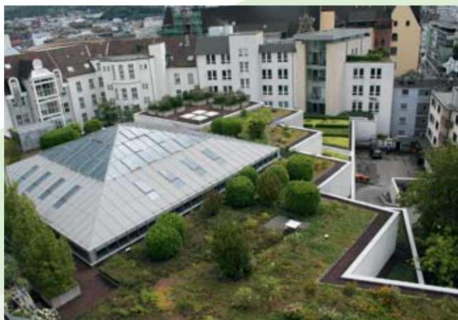
De begroeiing van 'intensieve groendaken' kan bestaan uit grassen, kruiden, struiken en zelfs volwassen bomen.
