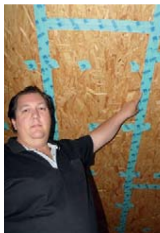
Links: Het gebruik van kleefband helpt spleten en kieren te dichten.
