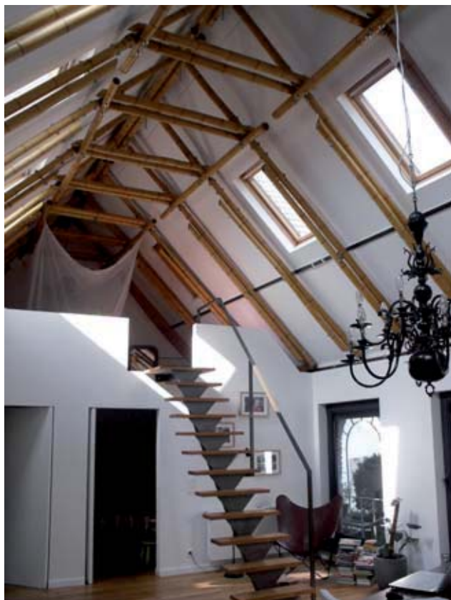
⋮ Sven gebruikte bamboe voor de dragende elementen van een nieuw dak.
